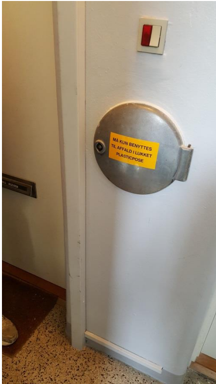
Figur 12: Lodret kabelkanal i opgang.
