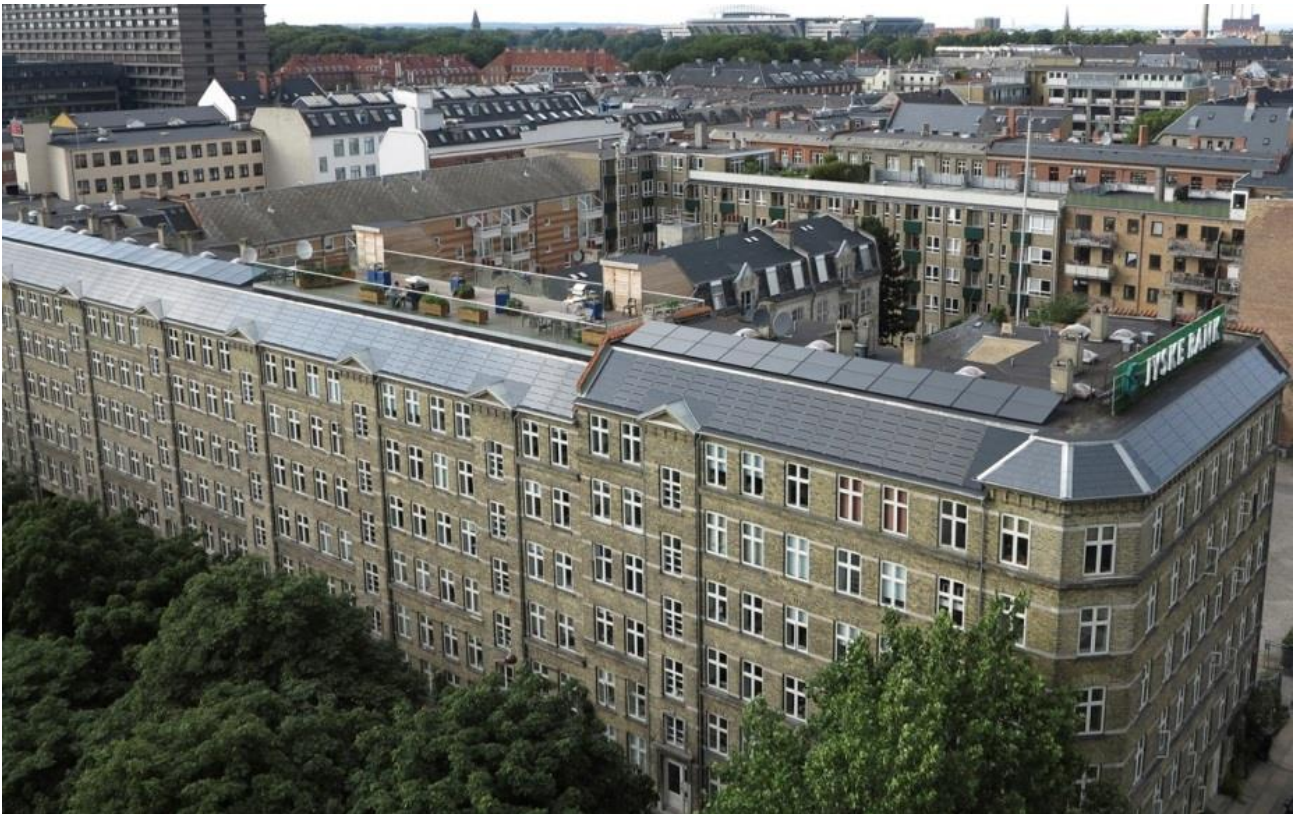
Figur 6: Sjøpassagen, København: BIPV-anlæg på de skrå, vest- og sydvendte tagflader, hvor de substituerer traditionelle skifertegl. Omkring skyggekastende tagudspring er anvendt "dummy-paneler". Udførelsen skyldes tagfladens bevaringsværdighed. På den vandrette tagflade er opsat to rækker konventionelle, sorte paneler på stativ, der giver den fornødne hældning (Foto: Gaia Solar)
